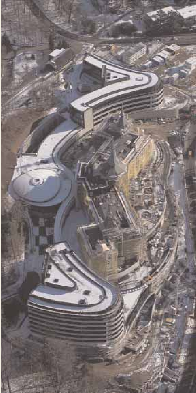
Dolder im Bau Luftaufnahme: Entsteht hier ein neues Wahrzeichen für unsere Stadt Zürich, das ebenso bekannt wird, wie das Grossmünster und der Uetliberg?
